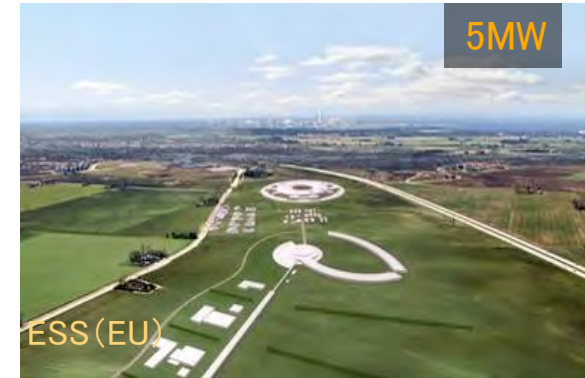
現在建設中。利用開始は2023以降
