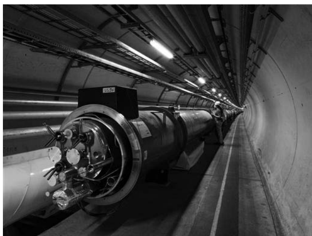
図2 LHC加速器。約1700台の超伝導マグネットを据付中のLHCトンネルの写真(CERN提供)
